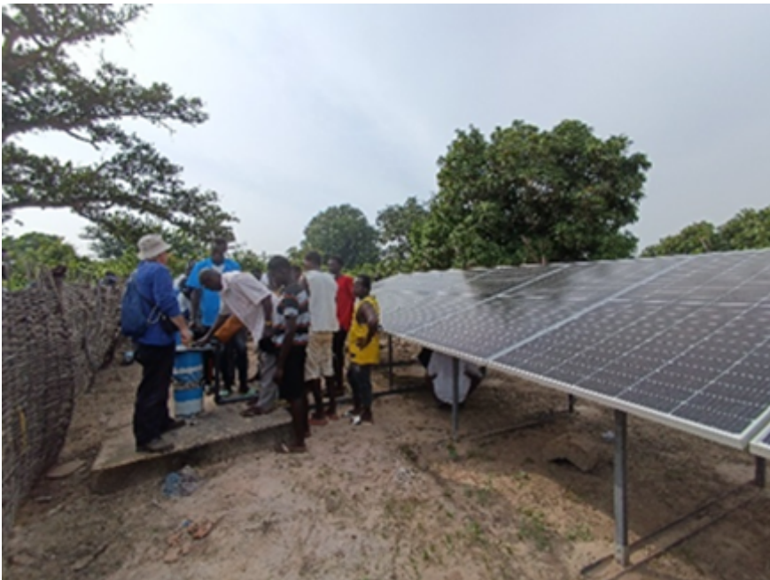
Forage et pompe solaire installée par le projet
