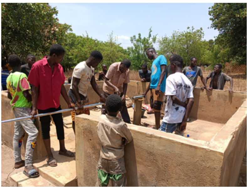
Réparation forage de Zono
