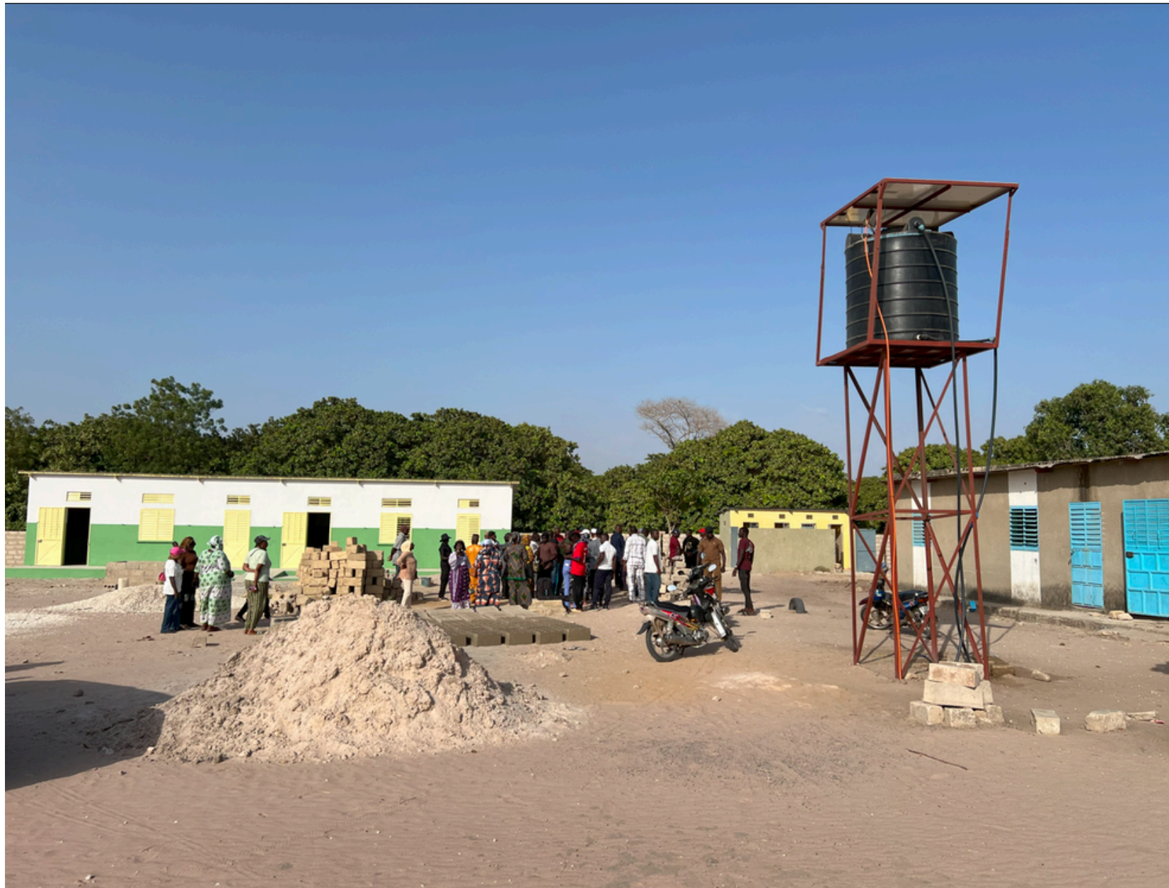
Tower Tank, Karang, Sénégal
