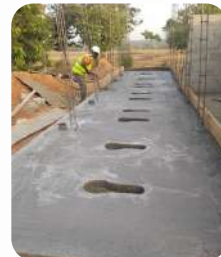
Travaux de latrines
