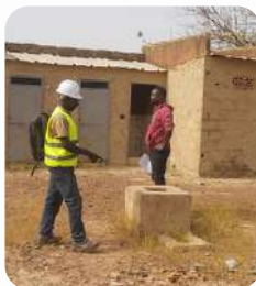
Démarrage travaux latrines
