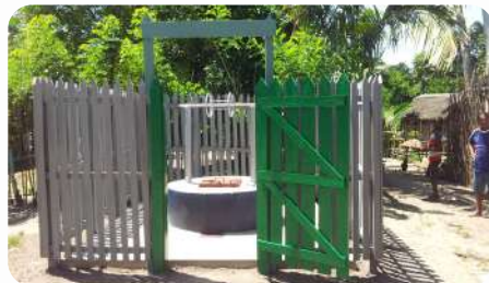
Fanivelona - Un puits terminé
